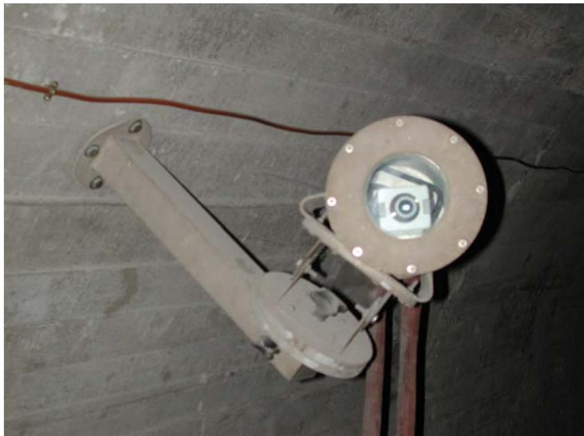
**Figura 7. Cámara de color con carcasa de protección.**
