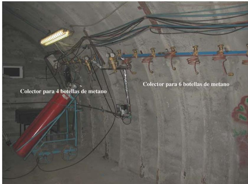
Figura 2. Sistema de inyección de gas metano.
